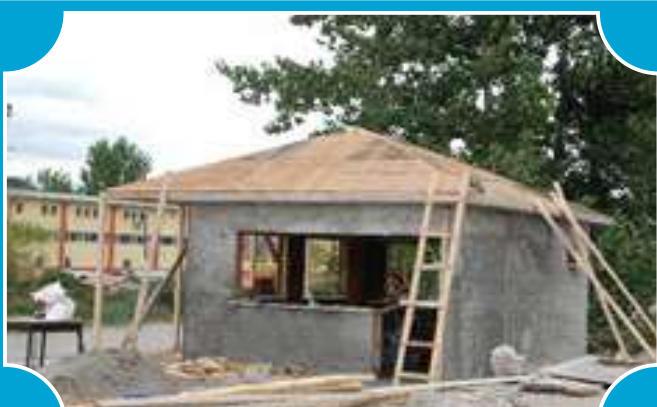
MEZBAHANE GÜVENLİK KULÜBESİ
