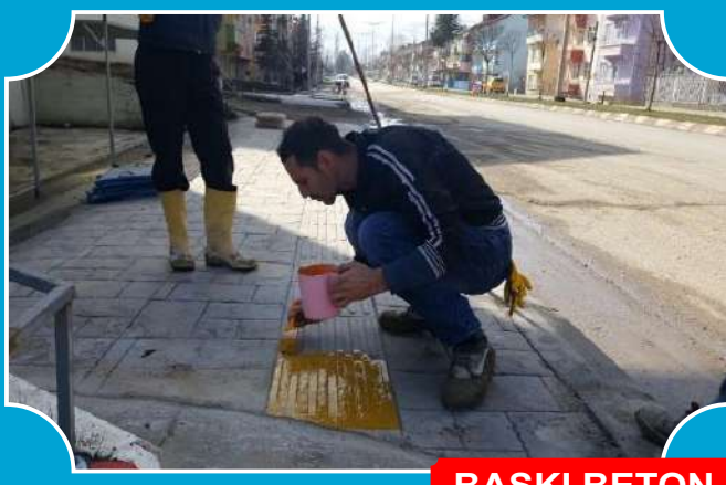
BASKI BETON SONRASI BOYAMA
