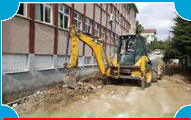
Atatürk İ.Ö.O. Kanalizasyon ve Parke
