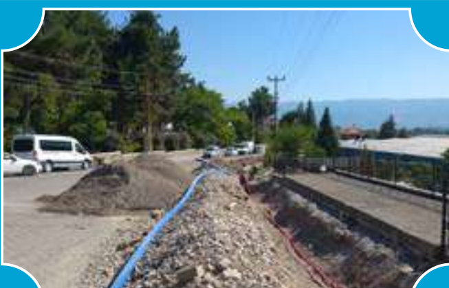
Elektrik Hattı Çekilmesi
