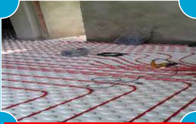
Hz. Ali Camii Taban Isıtması
