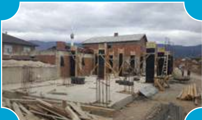
MAHMUDİYE MAHALLESİ KONAĞI
