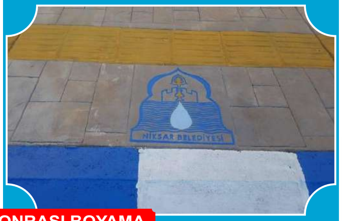
BASKI BETON SONRASI BOYAMA
